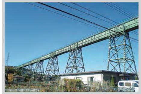
昭和27年に完成した長さ306mの水路橋です。橋の中には相模湖からの水が流れています。かながわの橋100選に登録されています。
